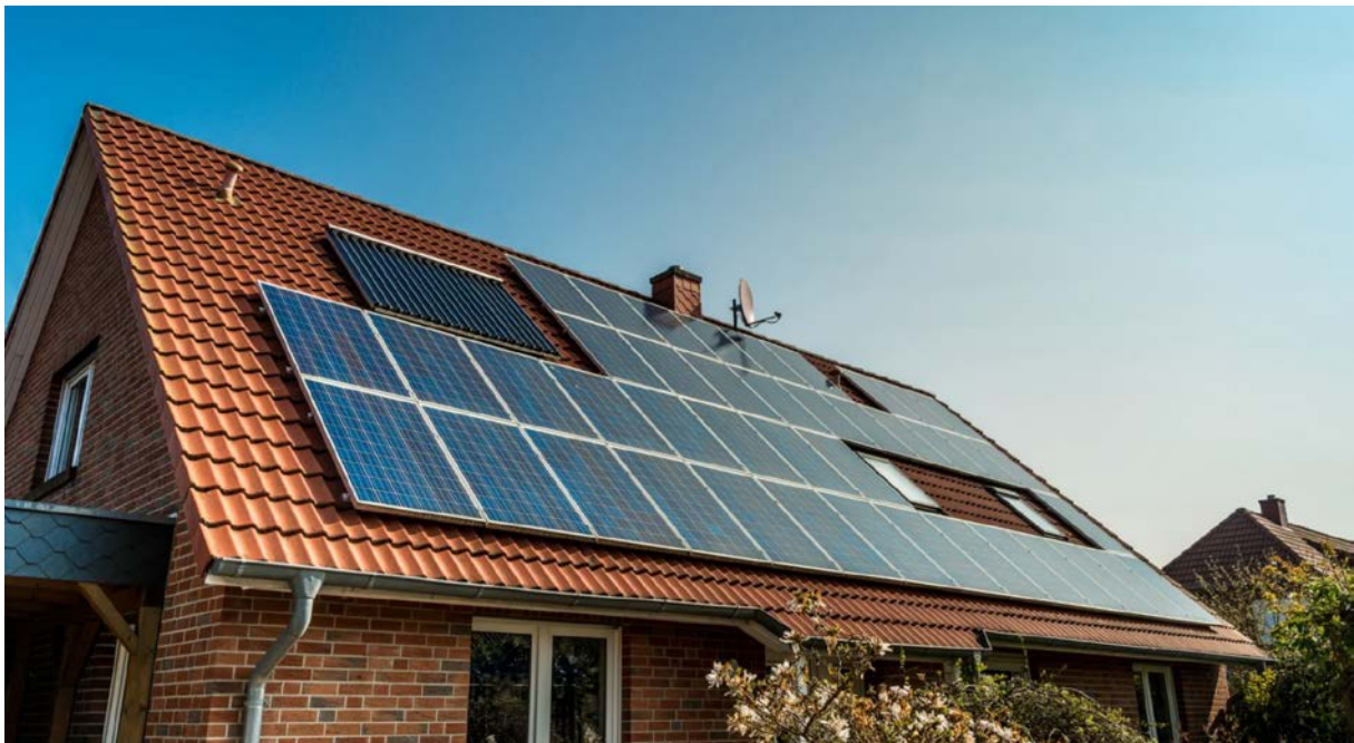
Opbouw zonnepaneel installatie met een enkele zonnecollector
